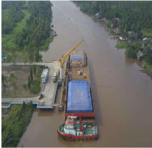
MAIN JETTY Crane Capacity : 40 ton
