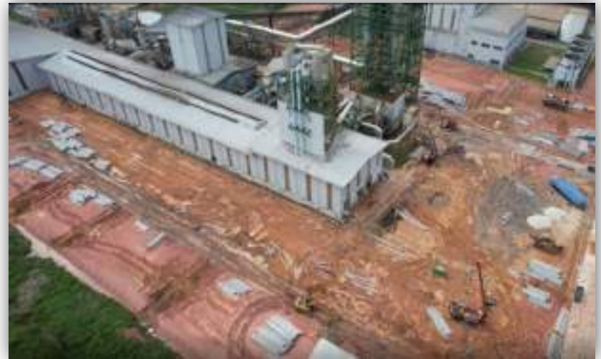
MDF Building – tahap pemancangan
