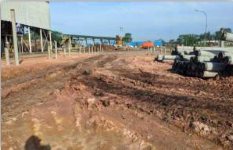
Barker Building – tahap pemancangan
