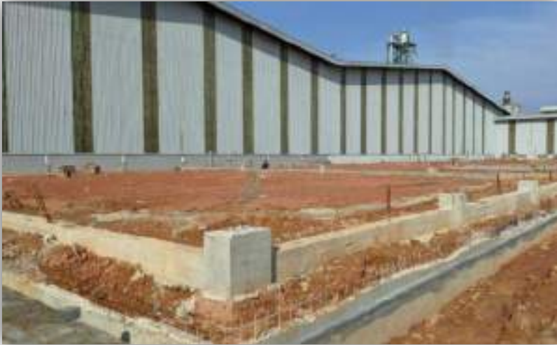
Rawboard Building – selesai tahap pemancangan
