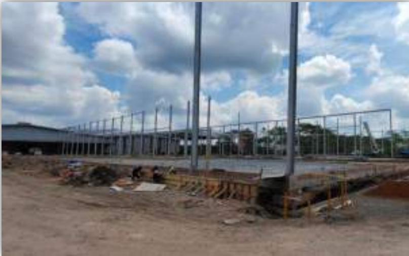
PPIC Warehouse – tahap pembangunan struktur
