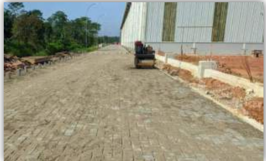
Progress Pembuatan Jalan
