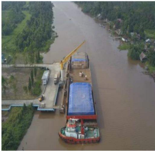
MAIN JETTY Crane Kapasitas : 40 ton
