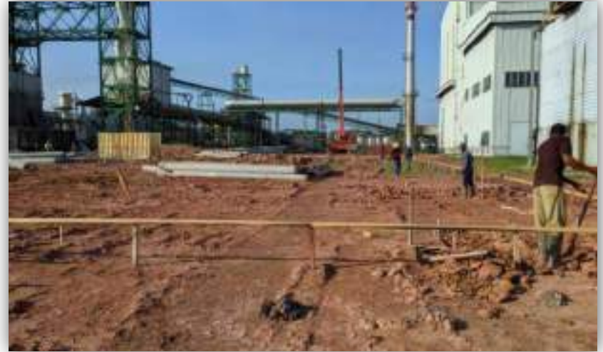
Refiner Building – selesai tahap pemancangan
