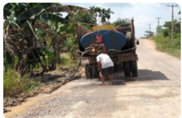
Kerja sama penyiraman jalan Kelurahan Bayung Lencir Indah dengan Lurah Bayung Lencir Indah selama tahun 2023. Cooperation in watering the road of Bayung Lencir Indah District with the Head of Bayung Lencir Indah Sub-District during 2023.
