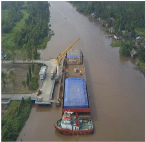
MAIN JETTY Crane Kapasitas : 40 ton
