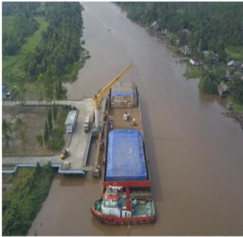
MAIN JETTY Crane Kapasitas : 40 ton
