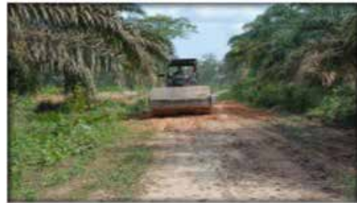
Bantuan biaya penimbunan jalan trans Cha Cha.
